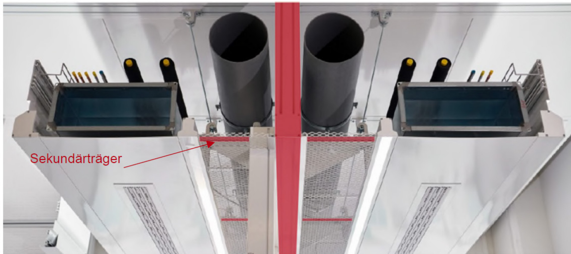
Deckenversorgungsmodul DVM Beispiel vollausgebauter Träger
